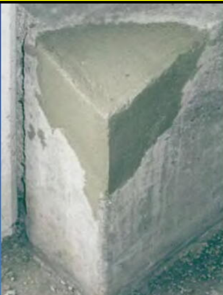
欠損部の修復
